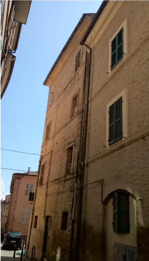
Figura 34 - Confine unità strutturale a sx - fronte via Rossi
