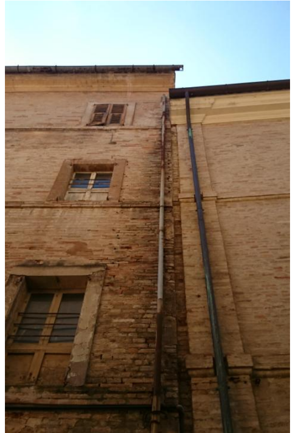
Figura 35 - Confine unità strutturale a sx - fronte via Rossi
