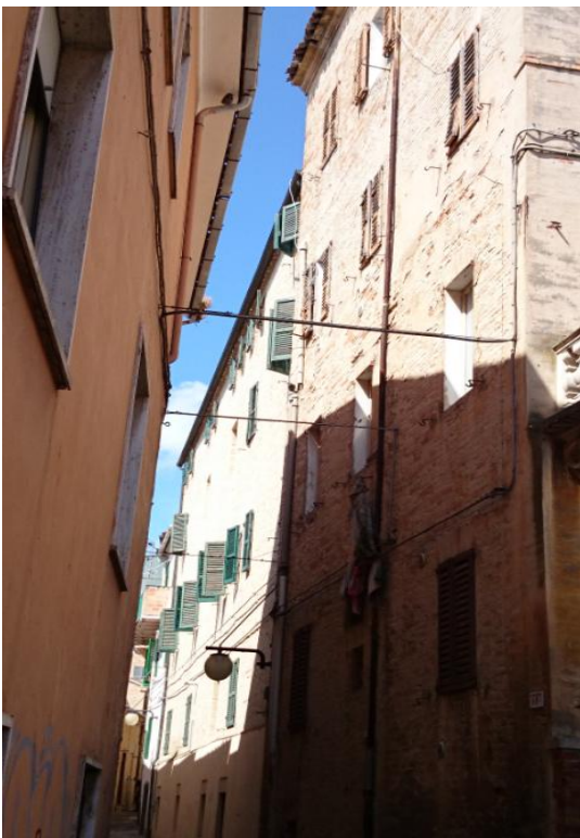
Figura 36 - Confine unità strutturale a dx - fronte vicolo San Carlo
